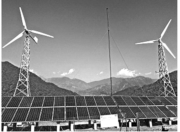
चित्र: ६.१: सिन्धुली जिल्लामा जडान भएको बायु तथा सौर्य ऊर्जाको हाइब्रिड प्रणाली । स्रोत: वैकल्पिक ऊर्जा केन्द्र
